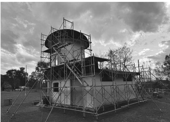
修繕中の山村広場管理棟
